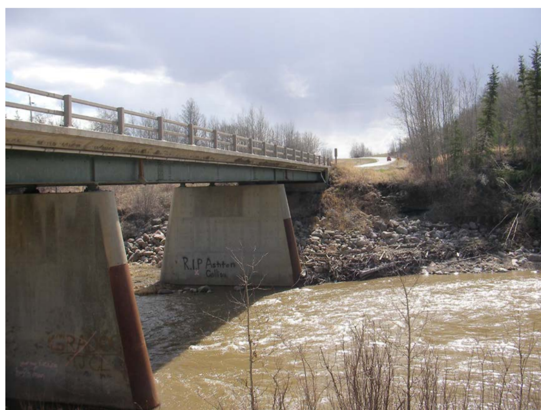
Le pont de trois portées au dessus de la rivière Redwillow
