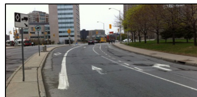
De gauche à droite : voie pour autobus, voie pour camions, voie cyclable et voie de circulation générale sur la rue Waller à Ottawa
