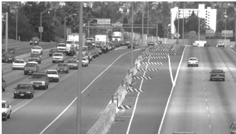
Figure 5 : Système typique de barrières automatiques, Seattle, Washington
