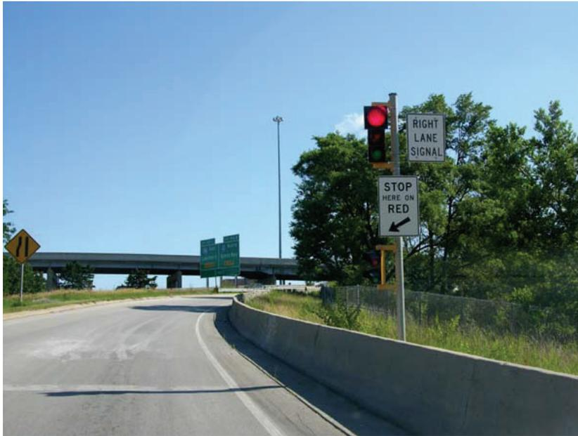
**Figure 5-3 Régulateur d'accès installé à Milwaukee, au Wisconsin**
