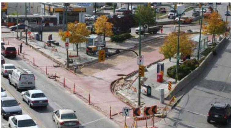
**Figure 7.1 : Traitement de surface au moyen d'un matériau de chaussée de couleur**
