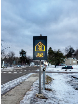
Exemple de PAV en zone scolaire sans indication de vitesse. Avenue Cleveland, Riverview (N.-B.)
