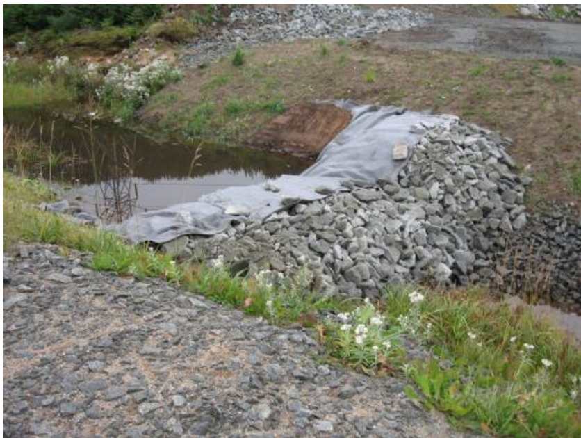
Photo 1 Berme filtrante modifiée en seuil
