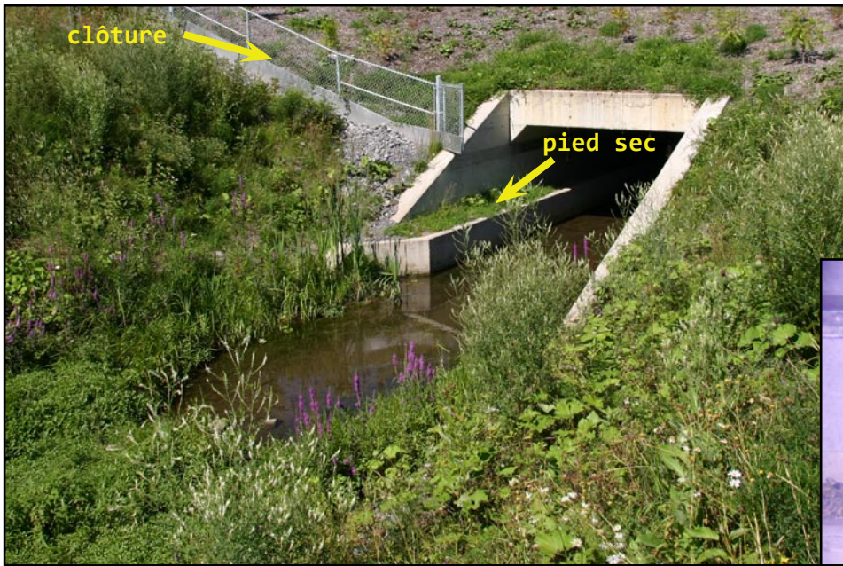
PHOTO 1 Pied sec et clôture pour la faune le long du ruisseau du parc de l'Escarpement
