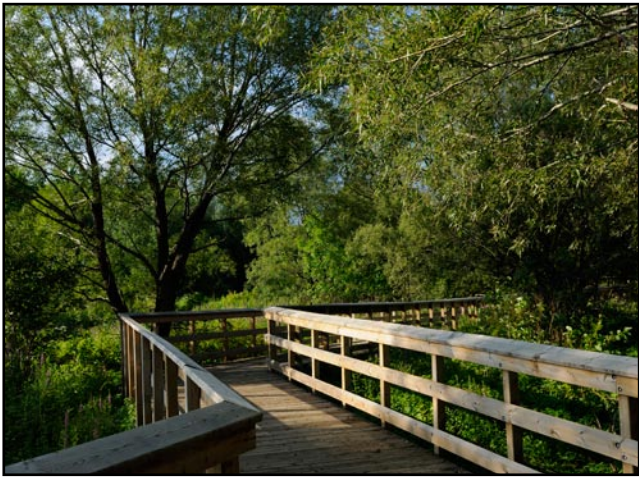
PHOTO 5 Passerelle sur pilotis traversant un petit marécage dans la partie nord du projet
