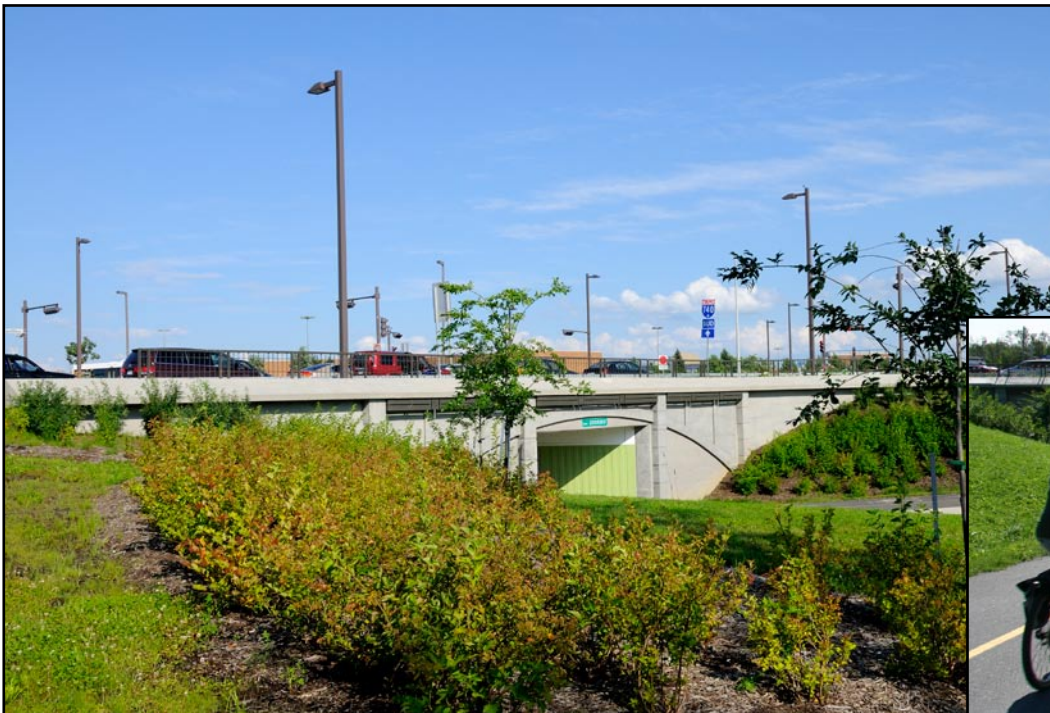
PHOTO 9 Tunnel cyclistes/piétons sous le boulevard Robert-Bourassa
