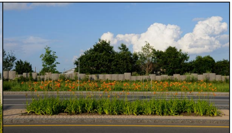
PHOTOS 14-15 Butte et mur antibruit fait de dalles de granit récupérées. À remarquer la gestion de la végétation de type extensive
