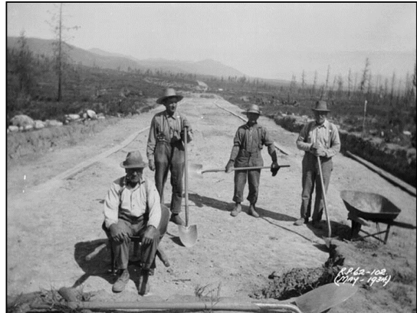
Projet d'aide au chômage du gouvernement fédéral, 1933; construction de route, Kimberly-Wasa, C.-B.
