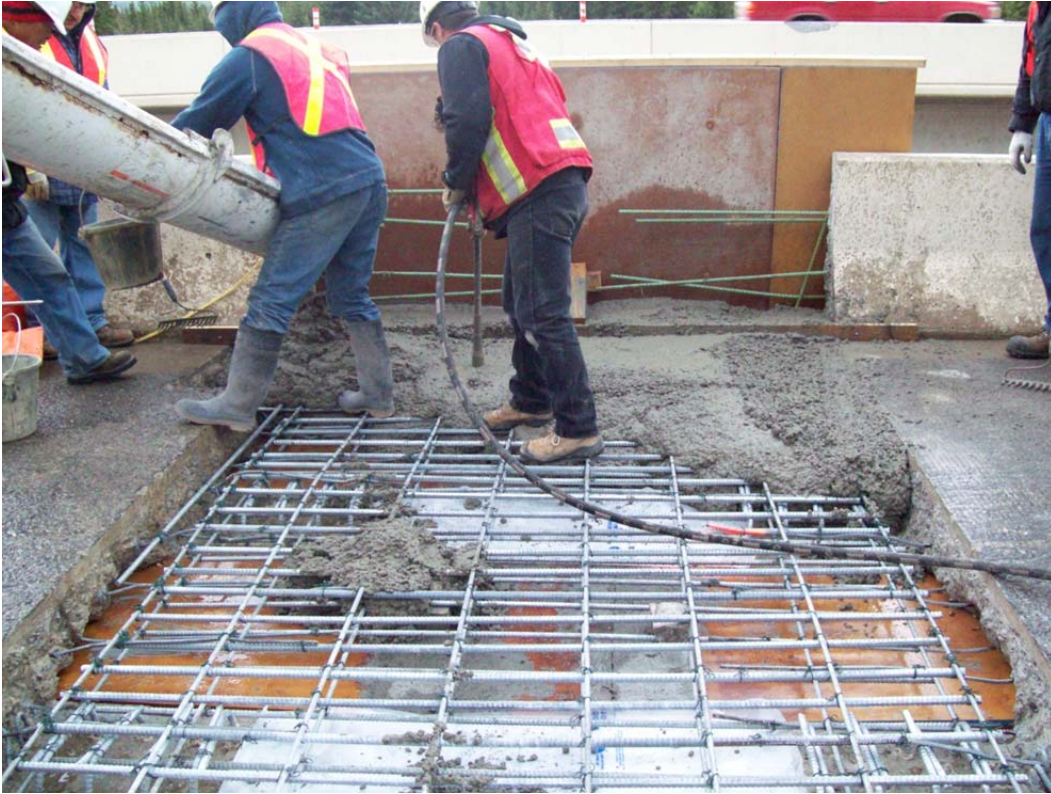
Figure 14) Pouring of link slab.
