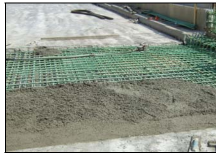
(b) Concrete Pour for Link Slab
