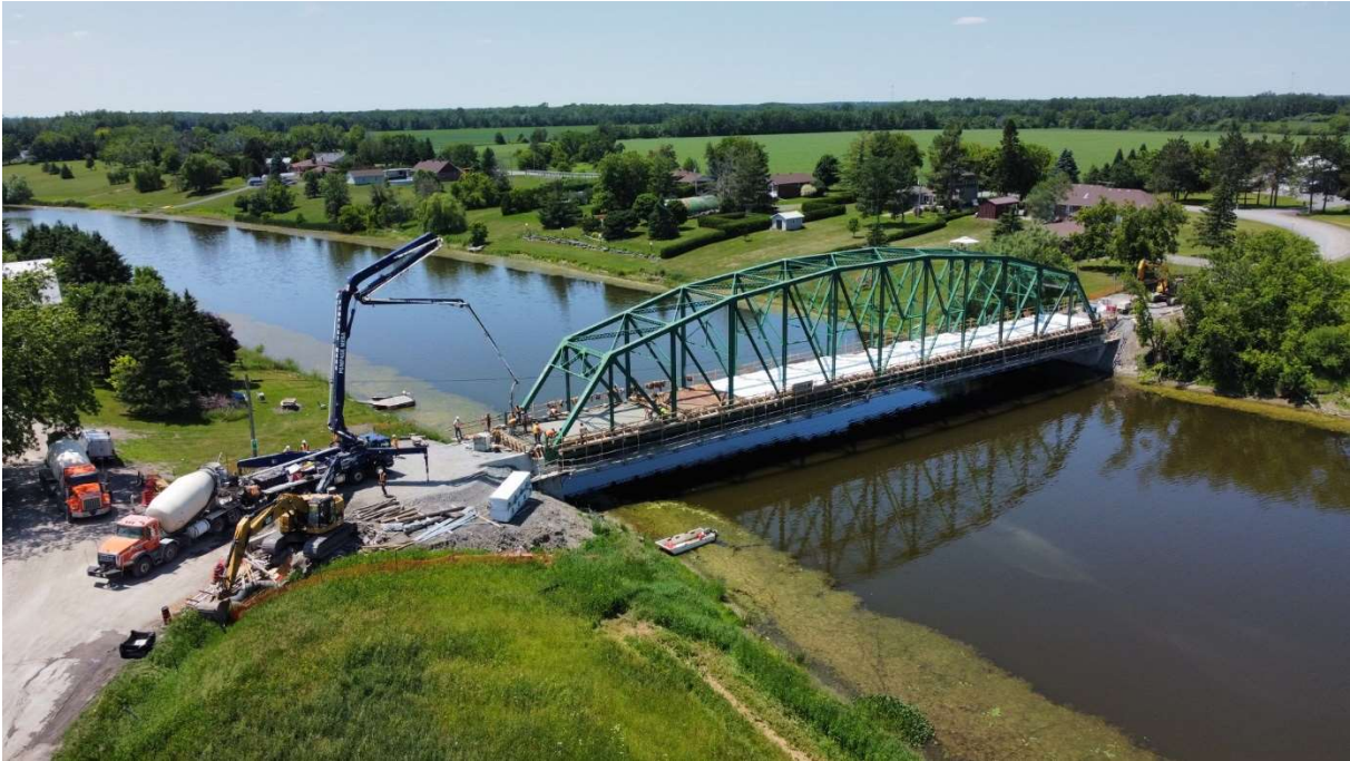
Figure 21. Concrete Deck Pour
