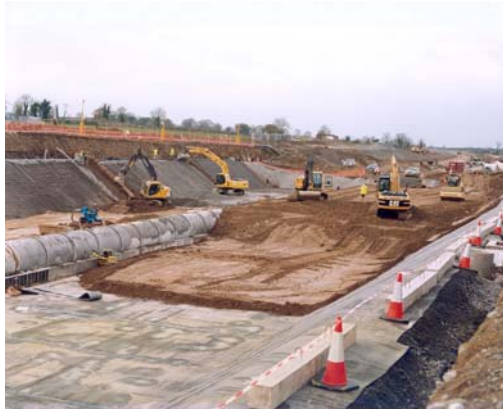
Photo 5: Collecteur central avec recouvrement de la membrane par O/75
