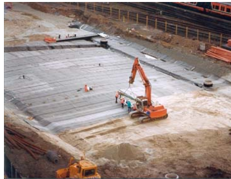
Photo 3: pose de la membrane
