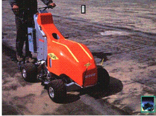
Photo 7: Contrôle par ultrasons avec appareil CAC 94
