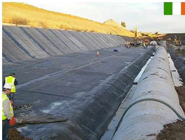
Photo 6: Recouvrement de la 1 ère demi-chaussée
