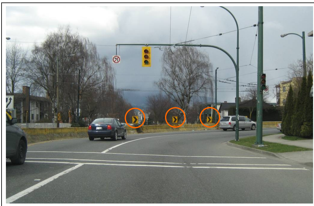
Photo prise sur une route urbaine à voies multiples avec chaussée séparée. Trois panneaux chevrons sont installés sur le terre-plein.
