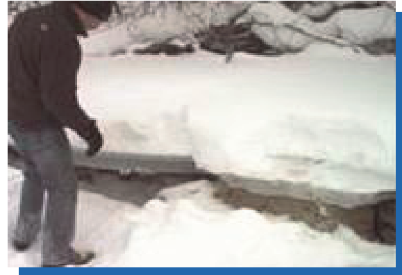
FIGURE 6-7 : Fissure à charnière le long de la rive d'un lac
