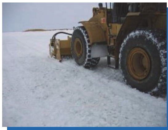
FIGURE 7-4 : Extraction des copeaux de glace (avec la permission de l'AIC)
