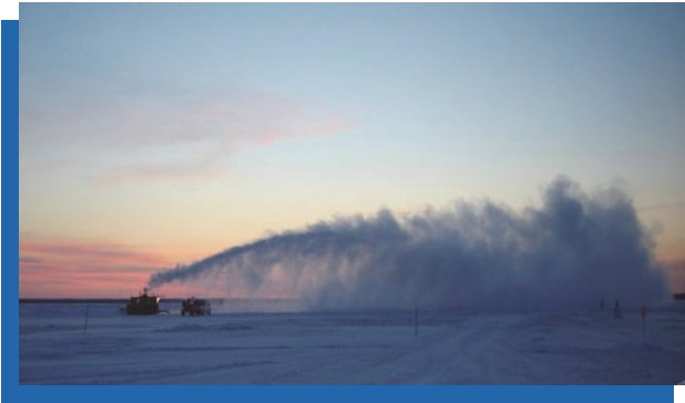
FIGURE 8-3 : Pulvérisation de glace sur la rivière Mackenzie (*Source : Ministère des transports du GTNO)
