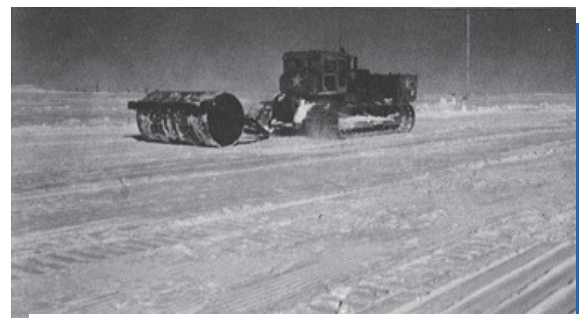
FIGURE 5-3 : Tracteur D8 compactant la neige à l'aide d'un tambour ondulé (selon Abele 1990)
