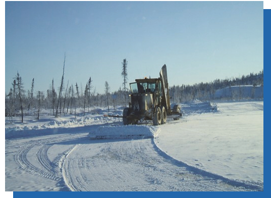
FIGURE 7-1 : Niveleuse tirant un traîneau niveleur sur la neige
