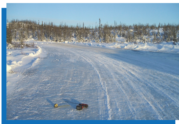
FIGURE 2-3 : Route de neige recouverte de glace dans les Territoires du Nord-Ouest
