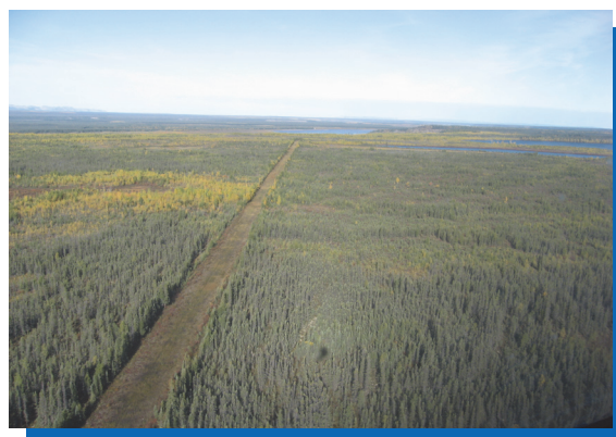
FIGURE 4-1 : Emprise dégagée dans les Territoires du Nord-Ouest
