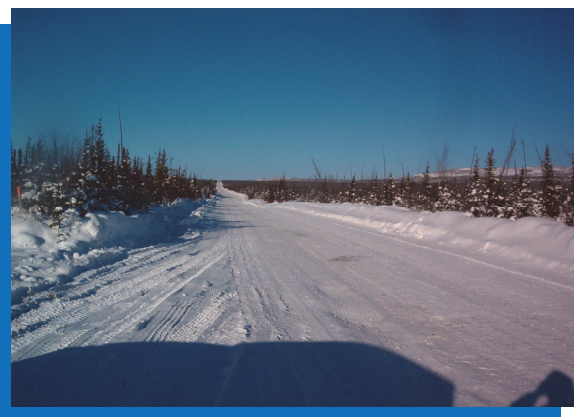
FIGURE 2-2 : Route de neige compactée dans les Territoires du Nord-Ouest
